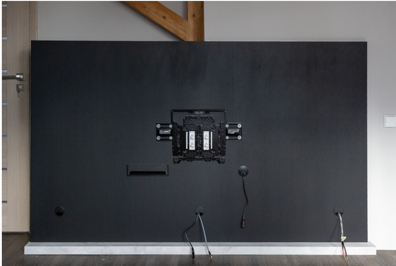
spersonalizowana ścianka multimedialna przed instalacją urządzeń audiowizualnych
