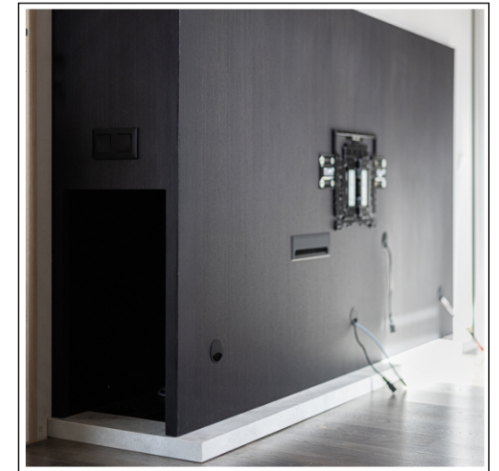
ścianka multimedialna (przed instalacją urządzeń audiowizualnych)
